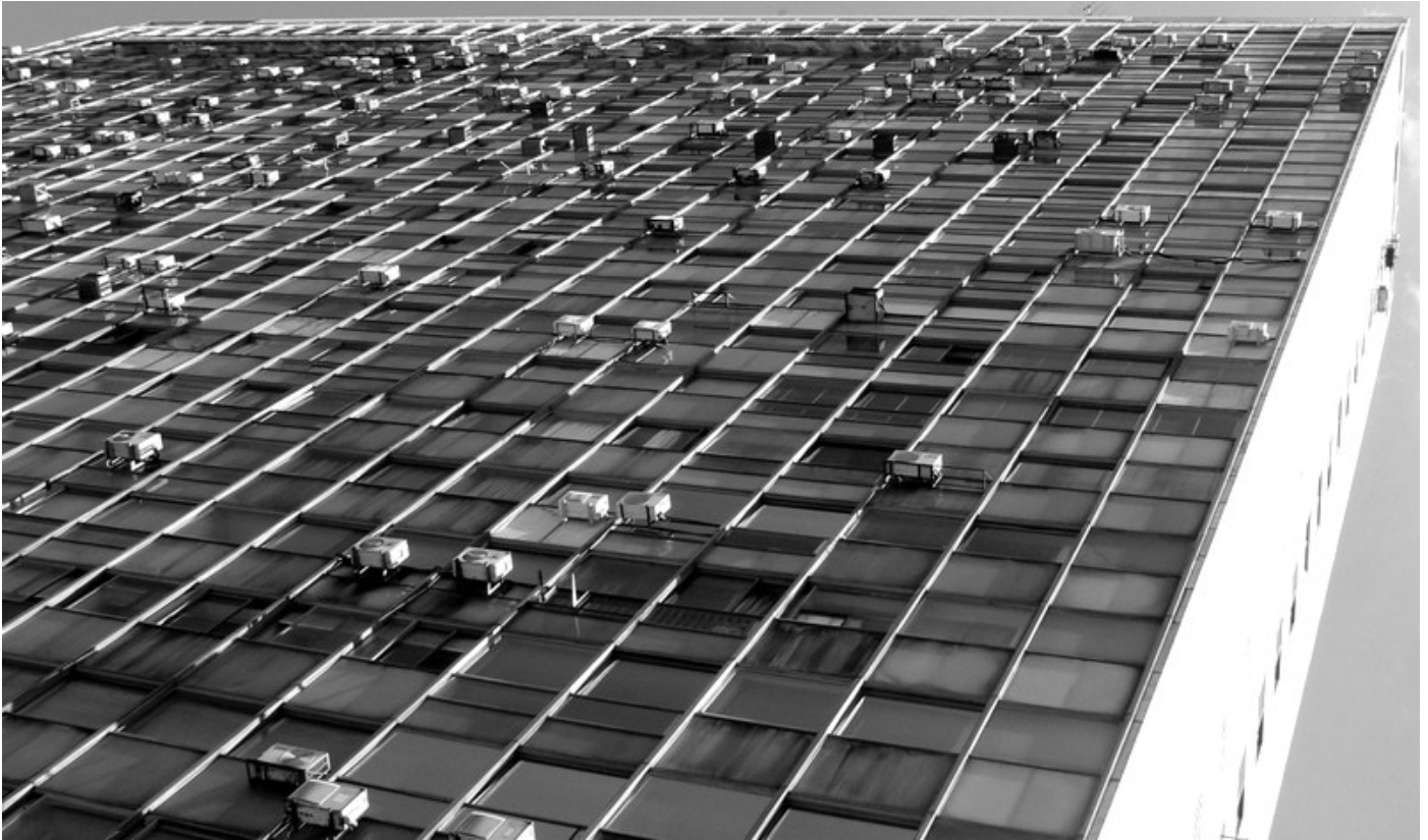
Figure 8 – Palacio de la Ciudadela a Montevideo, Arch. Sichero 1958. Web site: http://www.skyscrapercity.com/
